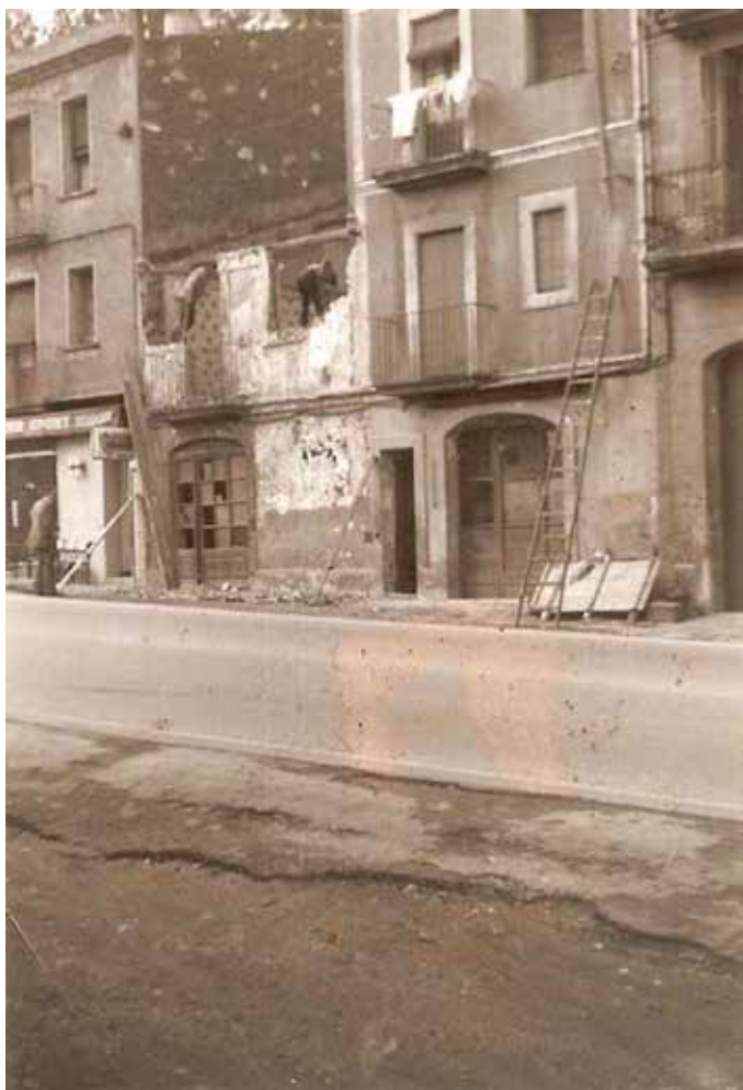
Edificis de l'Avinguda Josep Mensa, 20 i 26 amb l'enderrocament de ca la Cisqueta Mariàngela. Foto, arxiu Josep Pi
