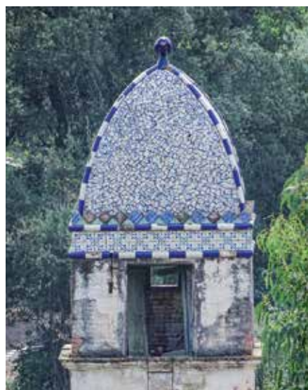
Detall de torre de l'aigua amb la cúpula de trencadis. Foto: Fermín Fernández
