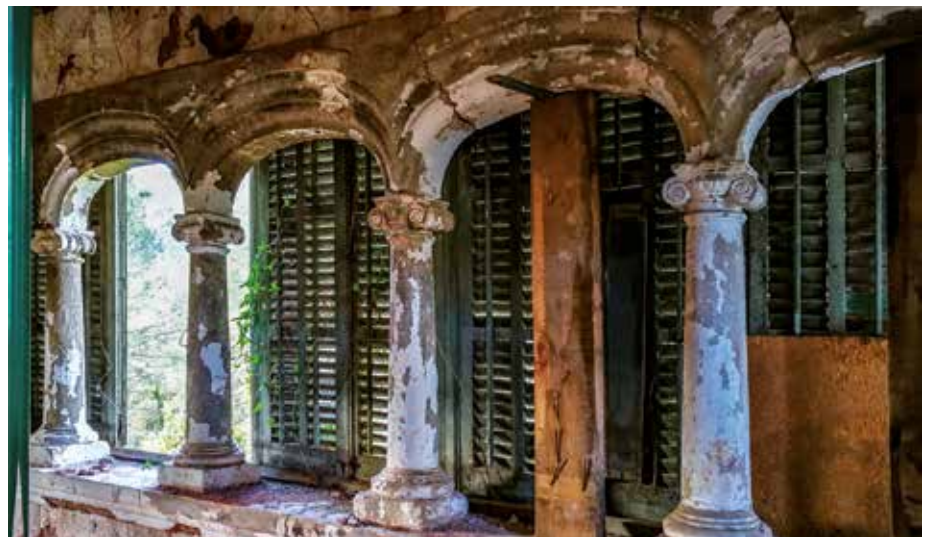
Finestres d'arcs rebaixats i columnes amb capitells d'estil jònic Foto: Fermín Fernández
